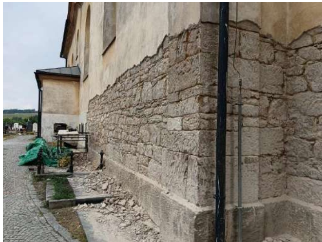
Z oprav kostela srpen 2025
